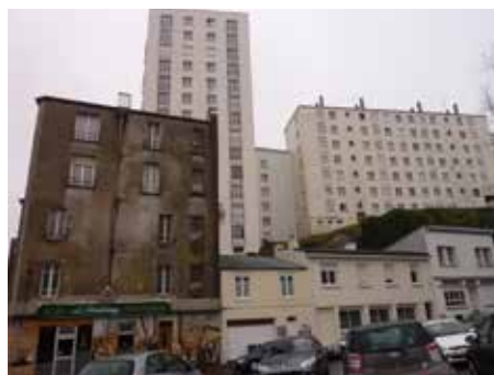
Des copropriétés parviennent à ralentir la dégradation en réalisant des travaux, par exemple ici sur certaines huisseries
