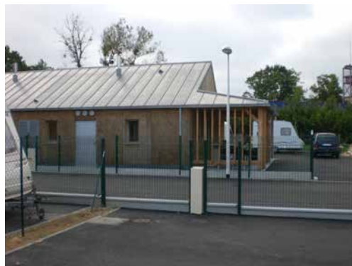
4 Logements adaptés - Gévezé
