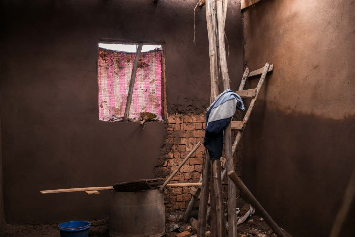
Sur le chantier de construction de la maison d'un bénéficiaire du programme LD2T dans le fokontany d'Ivolaniray en mars 2024.
