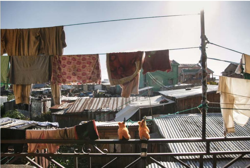
Vue générale des toits du micro-quartier n°4 dans le fokontany Anosibe II qui bénéficie du programme LD2T en avril 2023.
